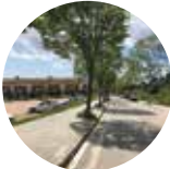
La millora del traçat del Passeig de Ronda, des del solar dels Bombers fins al carrer Pierola, al Pla del Castell.
