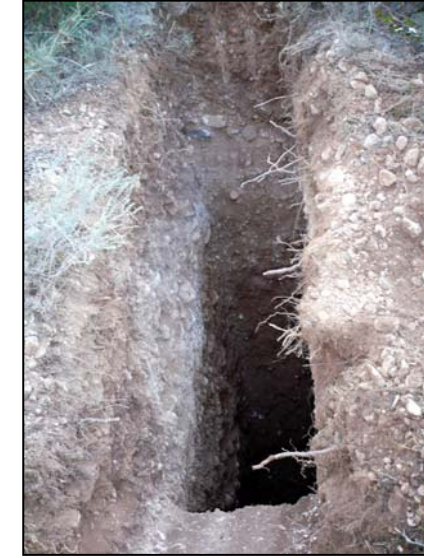
Foto 5: Excavació de la cata CT-1.
