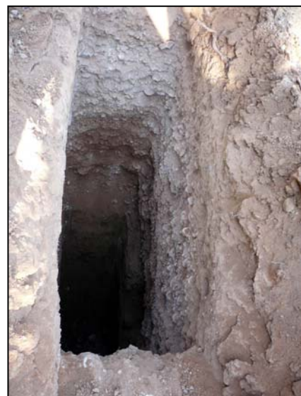
Foto 11: Excavació de la cata CT-4.
