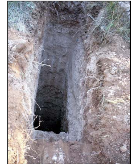
Foto 7: Excavació de la cata CT-2.
