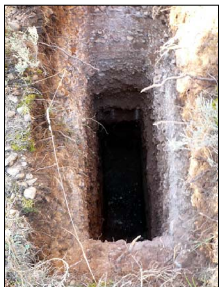
Foto 9: Excavació de la cata CT-3.
